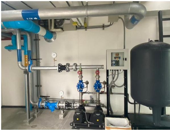
รูปที่ 20 ระบบปั้มน้ำาดาดฟ้า
